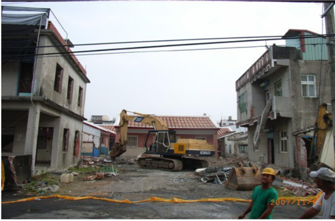
圖 8 楊家祖堂重建前樣貌之 2
