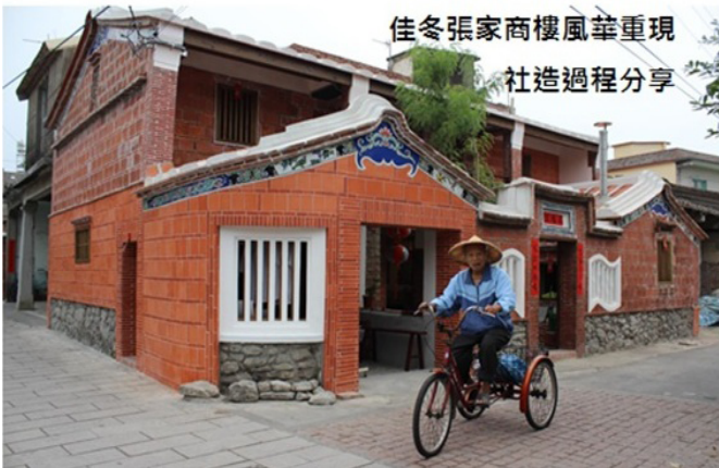
圖 12 張家商樓（張阿丁宅）整修後全貌
